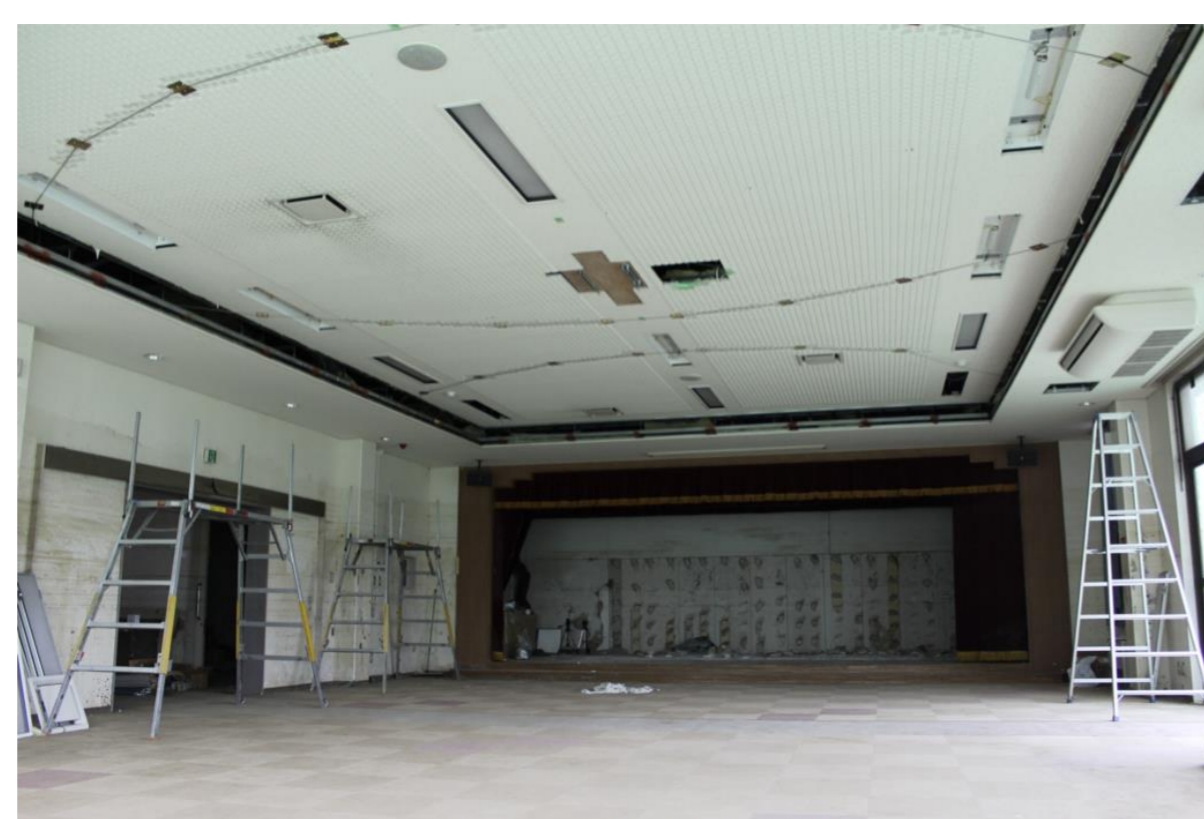
ケーブルによる天井の補強
