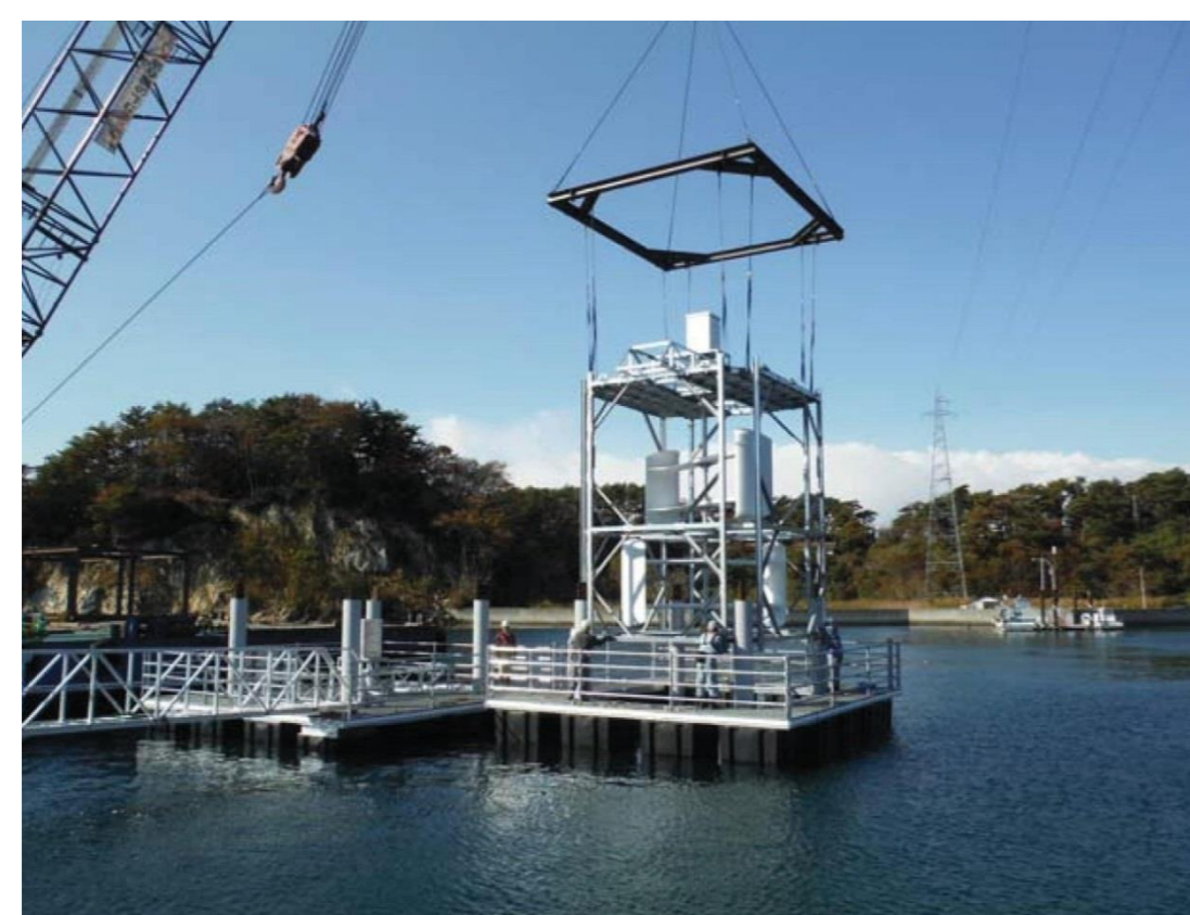
5kW 潮流発電装置の設置状況
