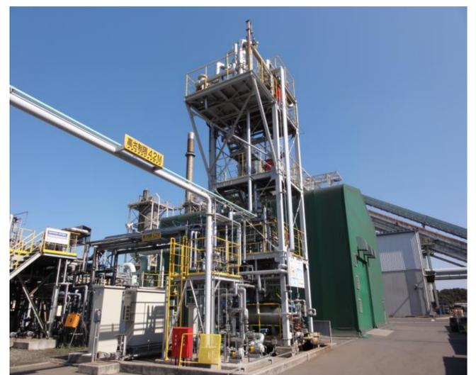
バイオエタノール製造用自己熱再生型蒸留装置
