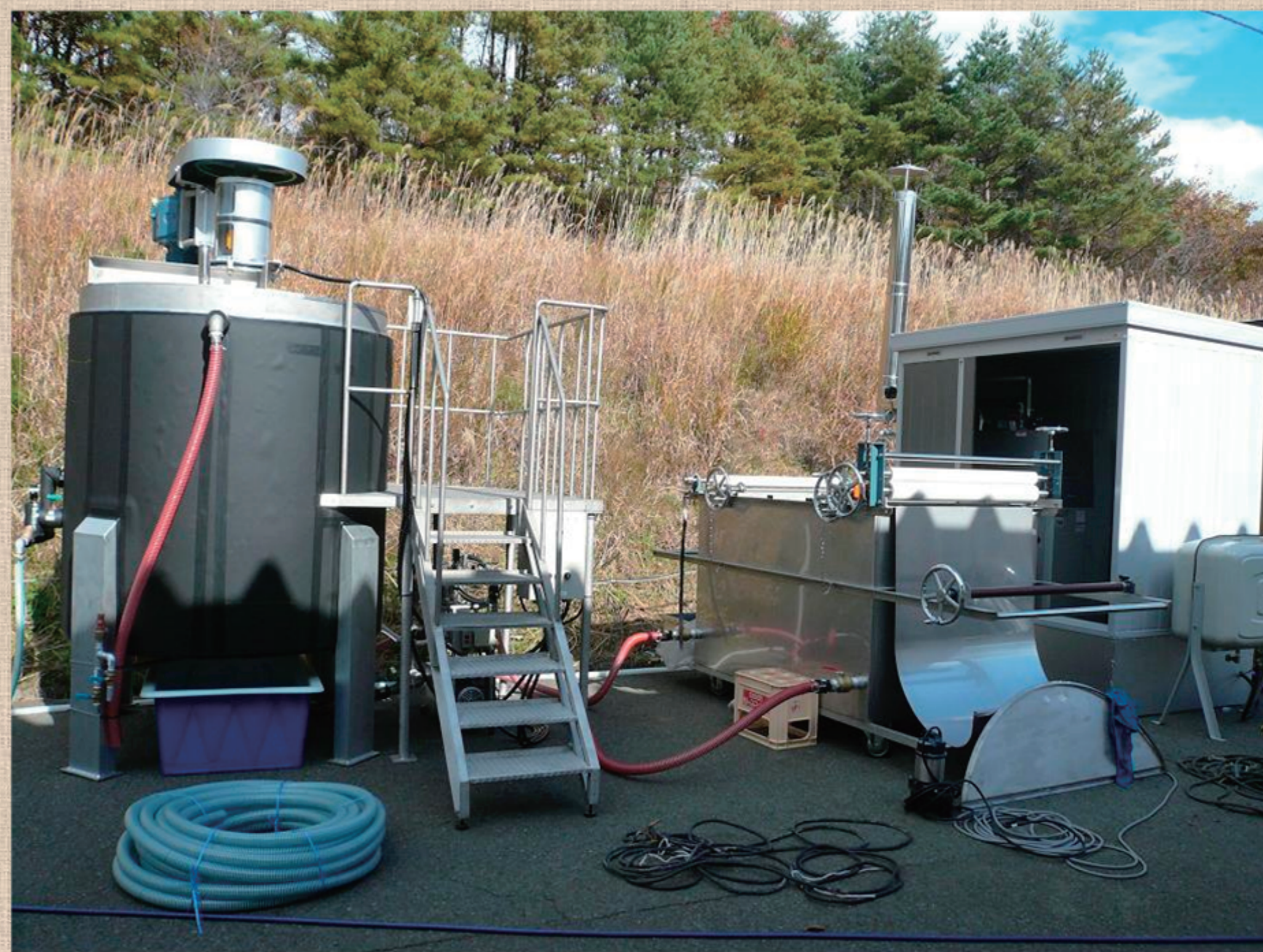
プロトタイプ装置による実証実験 (処理量:2ton-土壌/batch)
