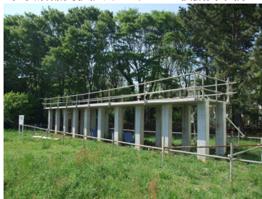
柱表層品質検証用RCラーメン模擬高架橋
