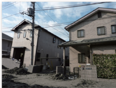
液状化発生前後の地盤強度の変化と液状化被害を受けた住宅
