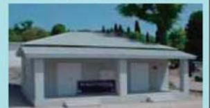
竣工した組積造住宅 (材料費は約3,000円)
