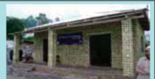
PP-band補強した組積造住宅の上塗り前
