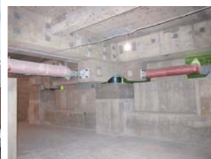
免震装置とオイルダンパーによる耐震改修
