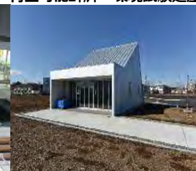
再生可能エネルギー環境試験建屋
