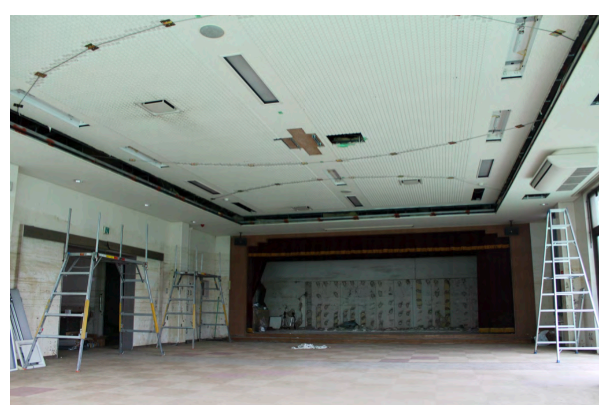
ケーブルによる天井の補強
