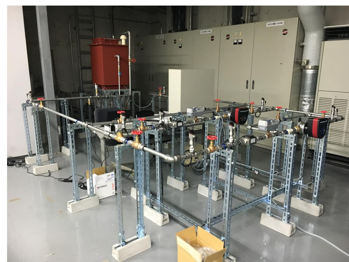
■ 空調用水搬送システムの配管実験
