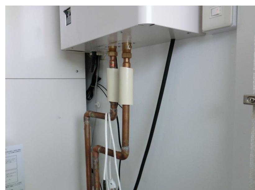
Boiler Thermal sensors ボイラー温度計
