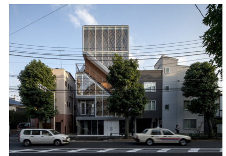
5階建て木造集合住宅 (下馬の集合住宅)
