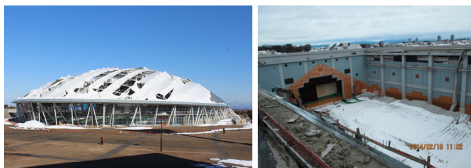
2014年2月14日の大雪による屋根崩落被害の調査
