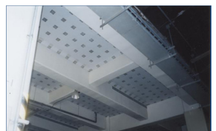
図6 炭素繊維シートによるRC床版疲労対策
