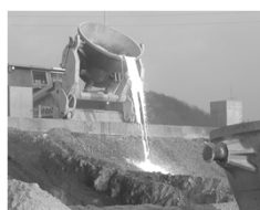
製鋼スラグの徐冷過程
